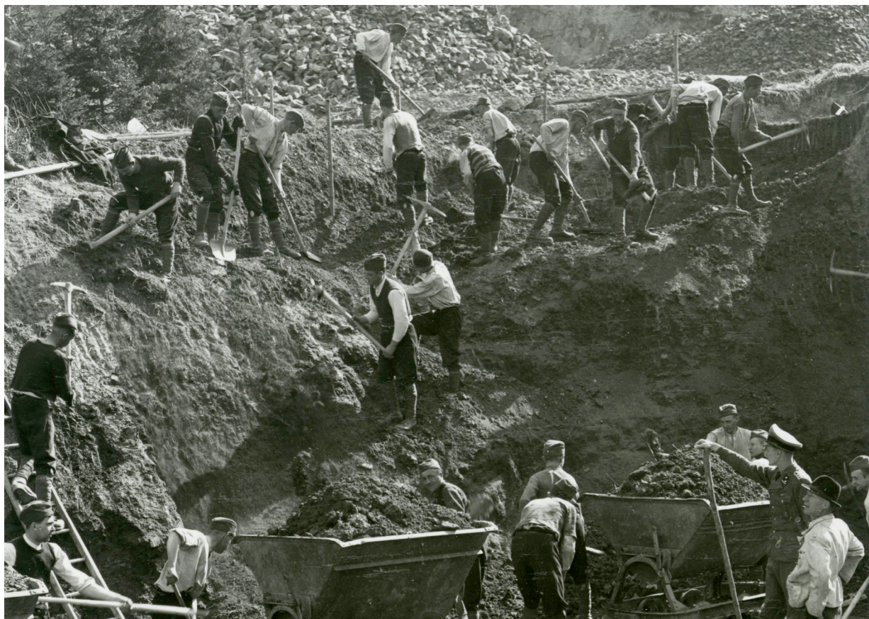
Skrývka a nakládání zeminy do vozíků, vpravo stojí velitel Henning, u něj zřejmě představitel či zaměstnanec jedné z firem zajišťujících práce na budovaném cvičišti
