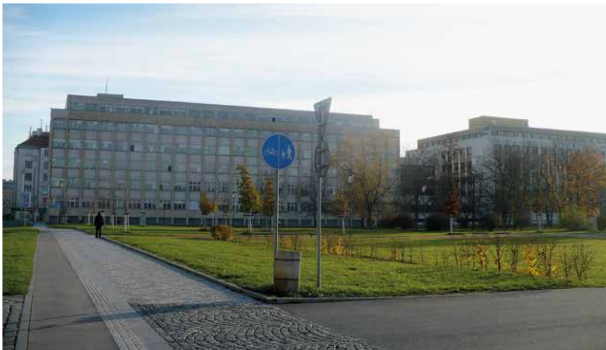
Objekt na pražské Letné, podle obložení stěn lidově nazývaný „Kachlíkárna“, byl vystavěn ve druhé polovině 30. let pro ministerstvo vnitra. Sídlilo zde vedení včetně náměstků, správa kádrů, inspekce apod. Nebyly zde umístěny téměř žádné součásti Státní bezpečnosti. (foto: Milan Bárta)
