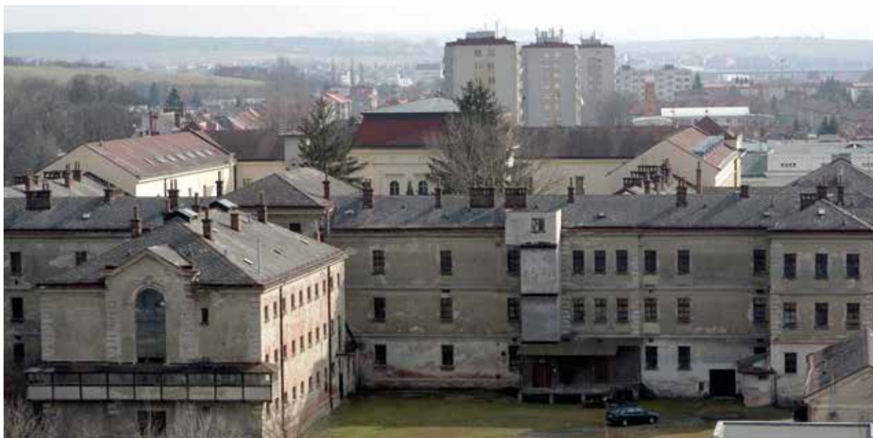
Bývalá věznice v Uherském Hradišti desetiletí chátrala a hyzdila centrum města (foto: ČTK)
