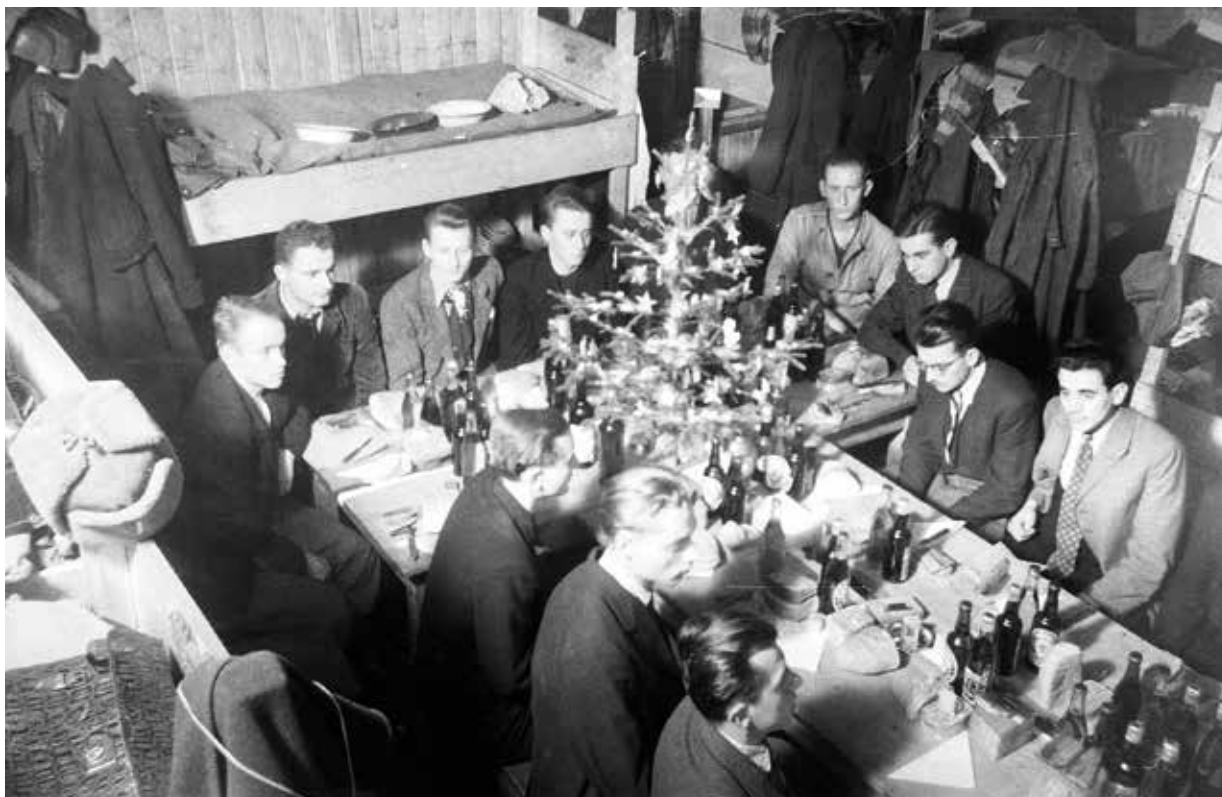
První Vánoce v lágru Strinda v Trondheimu v roce 1942. Pracovní skupina Milana Poledny přidělená na práce do Narviku dočasně pracující na stavbě ponorkového bunkru Dora I. Foto: archiv rodiny Jaroslava Malého
