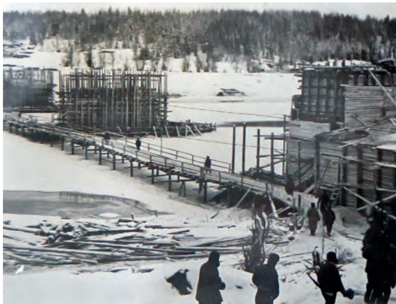
Vězni Gulagu stavějí most přes řeku Vym v Jemvě
