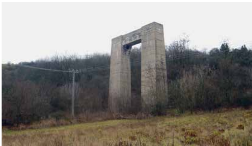
Pilíř nedostavěného mostu dálnice Vratislav-Vídeň pod hrází Brněnské přehrady
