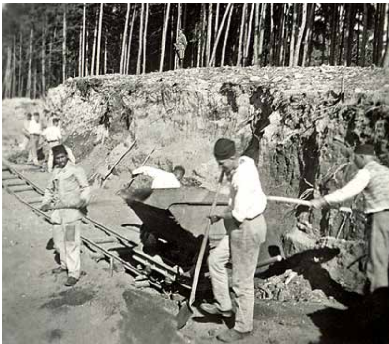
Stavba okresní silnice Lety - Staré Sedlo
