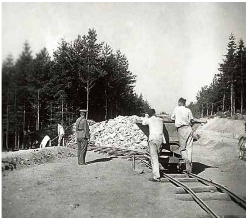
Práce na stavbě okresní silnice v úseku Lety - Staré Sedlo
