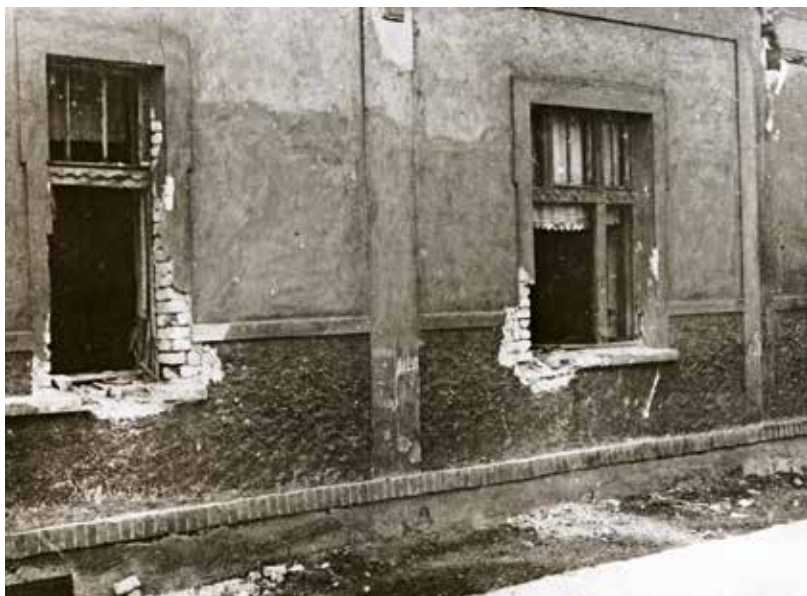
Okna v přízemí Fantova domu po útociích pumami
