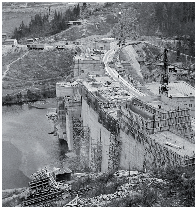
Na stavbě přehrady ve Víru na řece Svatce pracovali také řečtí emigranti, 1953
