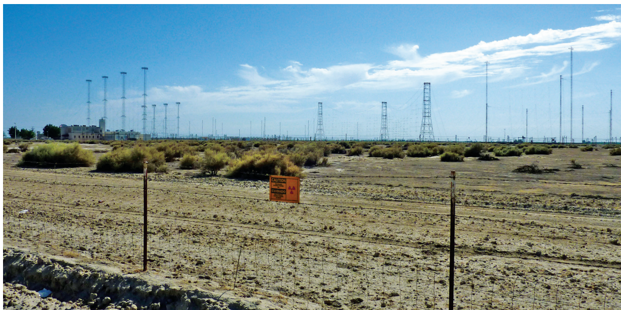
Les drátů a stožárů. Poslední „válečná“ vysílačka Hlasu Ameriky, Delano Transmitting Station v Kalifornii, byla uzavřena po 63 letech služby v říjnu 2007.
